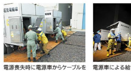
電源喪失時に電源車からケーブルを接続する訓練
